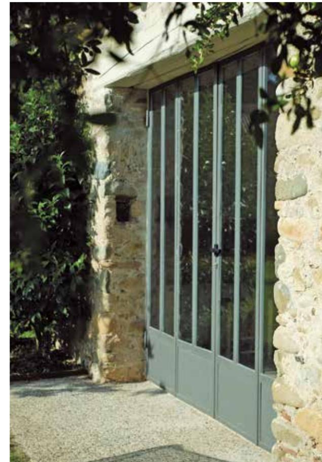
El pavimento es de hormigón pulido y abrigantado, paredes arremolinadas y pintadas, aprovechando la profusa iluminación natural con la recuperación de los grandes ventanales de carpintería de hierro. Se sacó provecho además de un antiguo almacén semi cubierto por el aparcamiento, taller y zona de limpieza del equipamiento deportivo.
